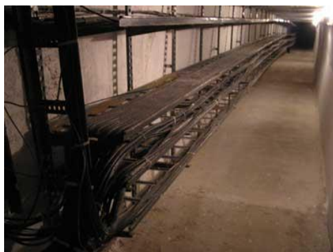
Рис. 1. Приклад кабельного тунелю прямокутного перерізу
