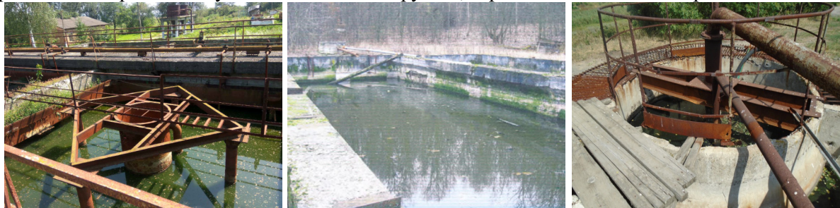
Рис. 1. Приклади технічно та морально застарілих каналізаційних комплексів населених пунктів України
