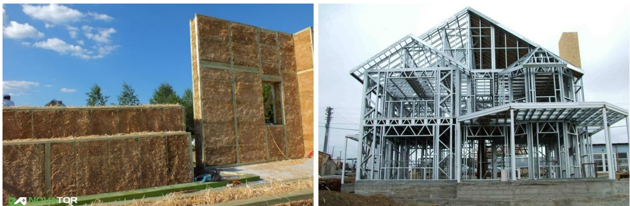
Рис. 1 – Каркасні системи будинків: а) будинок з соломи [2]; б) будинок з сталевих тонкостінних конструкцій [3]
