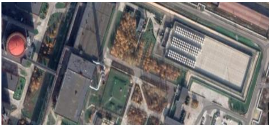
Рисунок 1 – Расположение СХОЯТ на площадке ЗАЭС. (На площадке справа в 10 рядах стоят бетонные контейнеры. Снимок Google earth в августе 2022г.)
