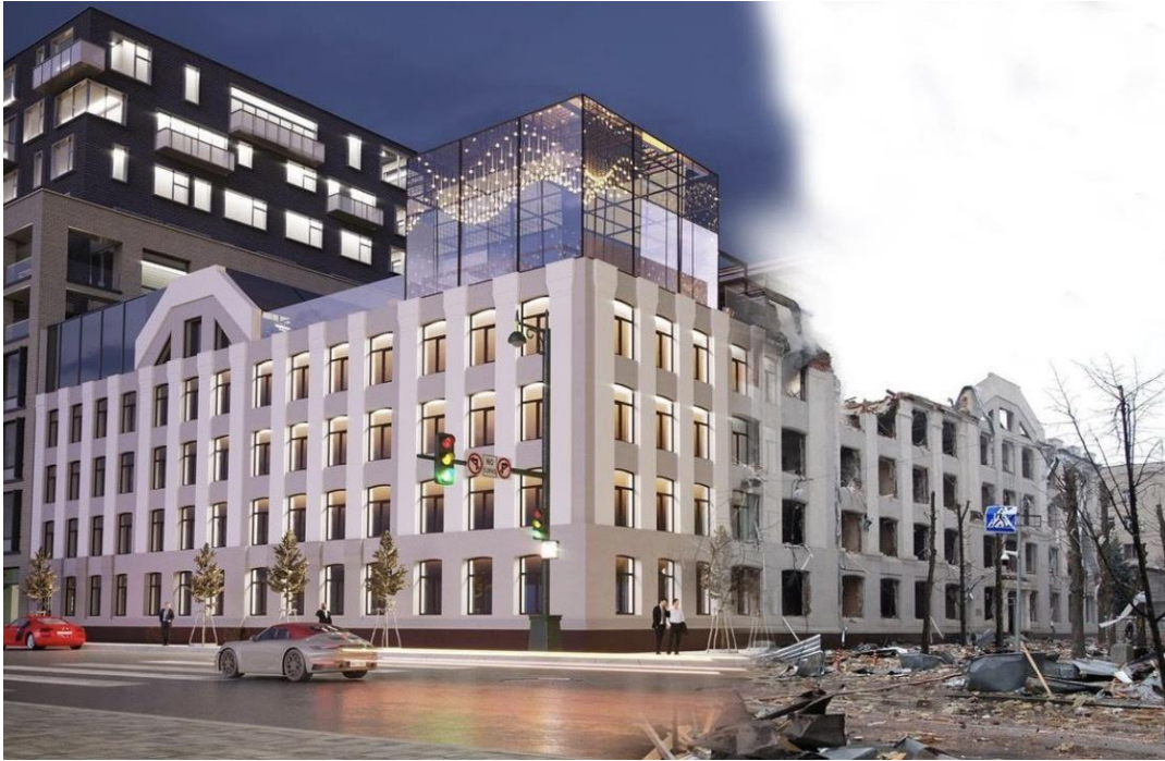
Рисунок 1 - Зруйнований корпус економічного факультету ХНУ імені В.Н. Каразіна
