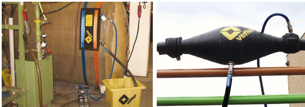
Рис. 4.12. Системи перекачування НХР із пошкоджених ємностей
