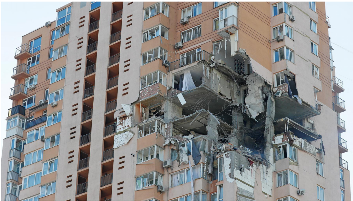
Рисунок 1 – Наслідки влучання ракети у житловий 25 поверховий будинок
