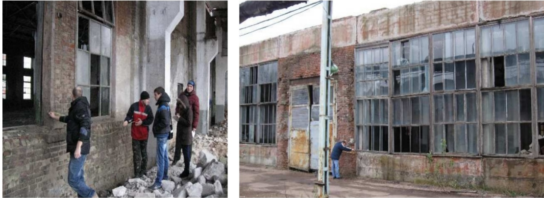
Рис.1 – Перевірка геометричних розмірів будівельних конструкцій.
