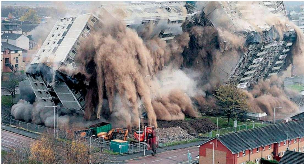
Рис. 1. Знесення аварійної житлової будівлі вибуховим методом
