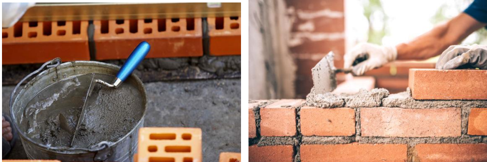
Рисунок 5.1 – Застосування мурувального будівельного розчину
