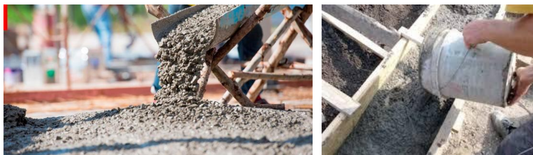
Рисунок 5.4 – Заповнення опалубки бетонною сумішшю
