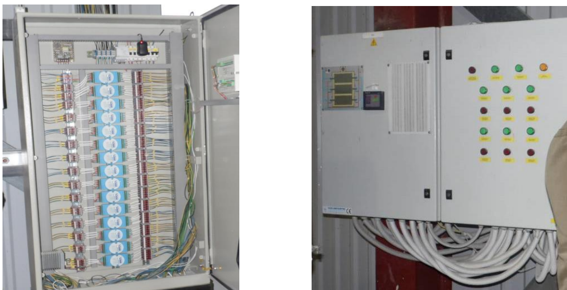
Рис. 2.3 Зовнішній вигляд схеми під'єднання термопар до вимірювально-реєструвального приладу
