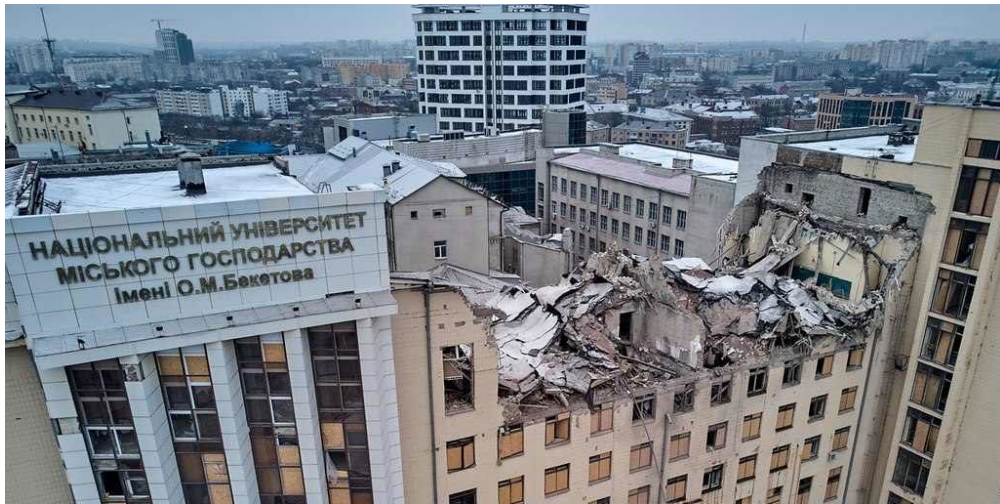
Рисунок 1 – Руйнування центрального корпусу ХНУМГ імені О.М. Бекетова, 2023 р.
