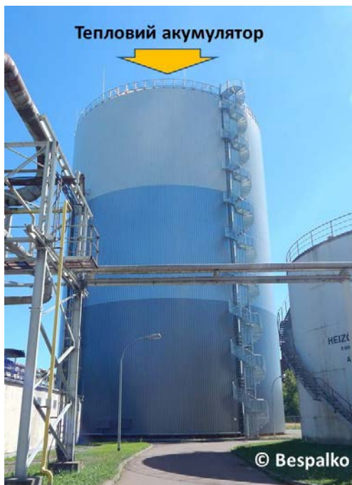
Рис. 7 Акумулятор теплоти розміром з 10-ти поверховий будинок (м. Десау-Рослау, Німеччина)
