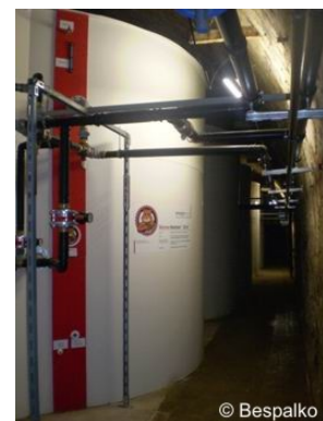
Рис. 5 (б) Підземні резервуари ємністю 50 м³ кожний для сезонного акумулювання теплоти сонячних колекторів (м. Десау-Рослау, Німеччина)
