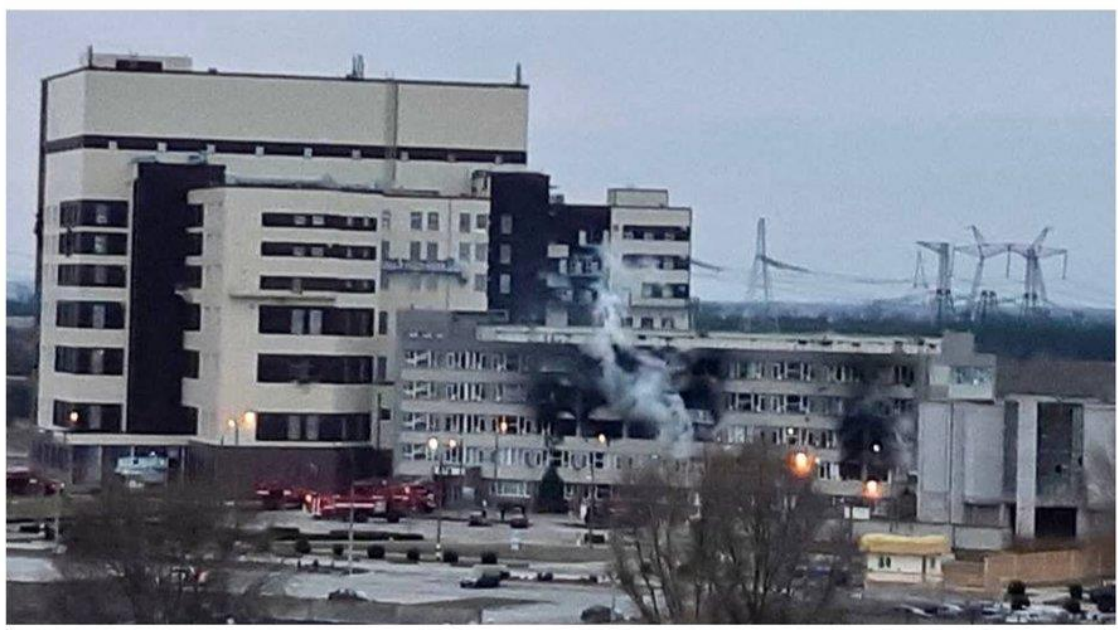
Рисунок 1 – Загальний вигляд ЗАЕС після обстрілів.
