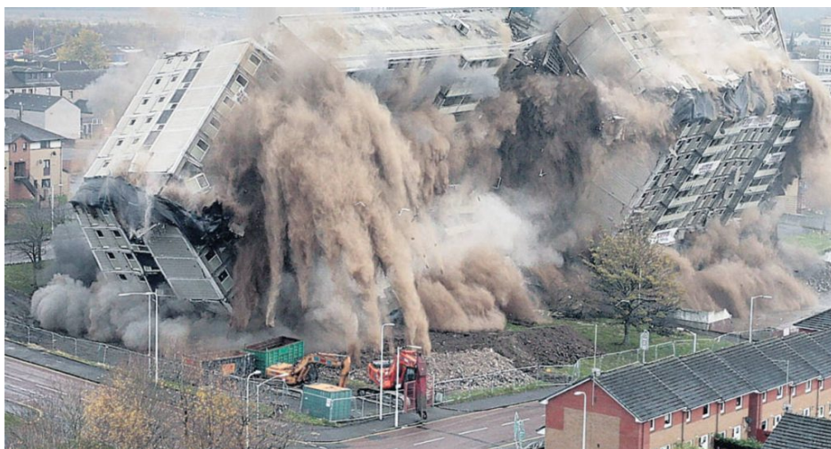
Рис. 1 – Знесення аварійної житлової будівлі вибуховим методом
