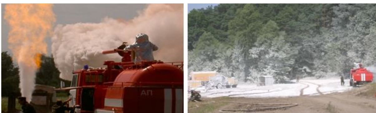
Рис. 4. Тушение газового фонтана порошковой струей
